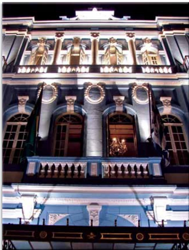
Área central da fachada frontal.
